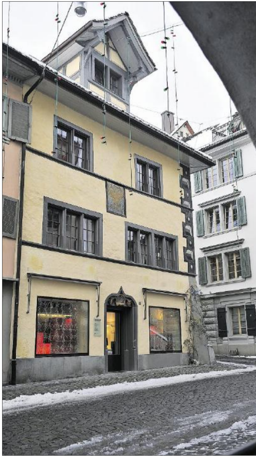
Mitten in der Rapperswiler Altstadt befindet sich an der Marktgasse 4 der «Goldene Adler». Im Jahr 2008 wurde der Umbau des Hauses abgeschlossen. (Manuela Matt)
